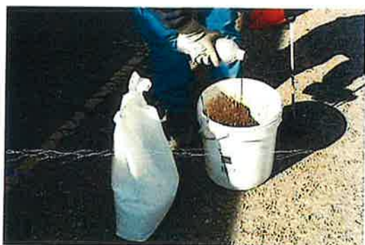
Secouer la bouteille de résine puis verser-la dans le seau contenant le reste de sable
