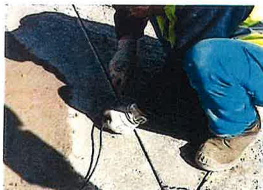
Placer la boucle puis la recouvrir d'une couche de sable d'environ 1 cm d'épaisseur.
