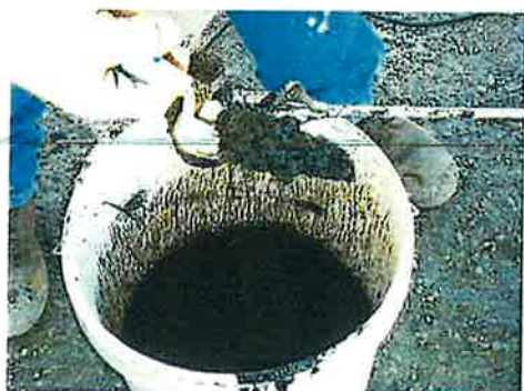
...jusqu'à obtenir un mortier homogène.
