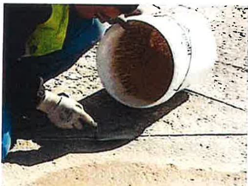
Déposer un lit de sable d'environ 1 cm d'épaisseur dans la saignée.
