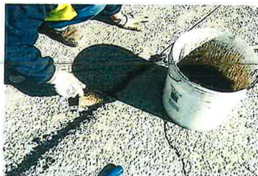
Recouvrir la boucle avec le mortier obtenu dans le récipient. Remplir la saignée jusqu'à la surface de la chaussée.
