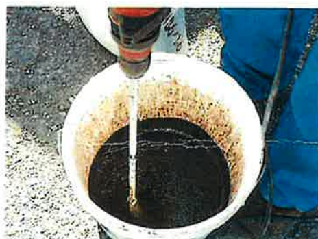
Mélanger la résine à la silice à l'aide de la perceuse équipée du malaxeur...
